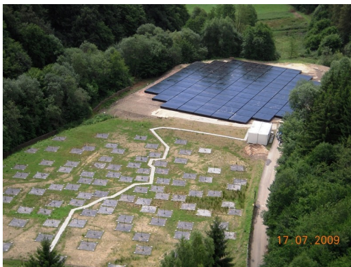
Abb. 1: Die erste deutsche LOFAR-Station in Effelsberg. Im Vordergrund die 96 Antennen für den Bereich 10–80 MHz ("Lowband"), aus je vier aufgespannten Drähten (2 Dipole). Die 96x16 Antennen für 110–240 MHz ("Highband") im Hintergrund sind in Styroporkästen eingelassen und mit Folie abgedeckt. In der Bildmitte rechts ist der Container mit der Elektronik für die Digitalisierung und Phasenverzögerung der Daten zu erkennen.
